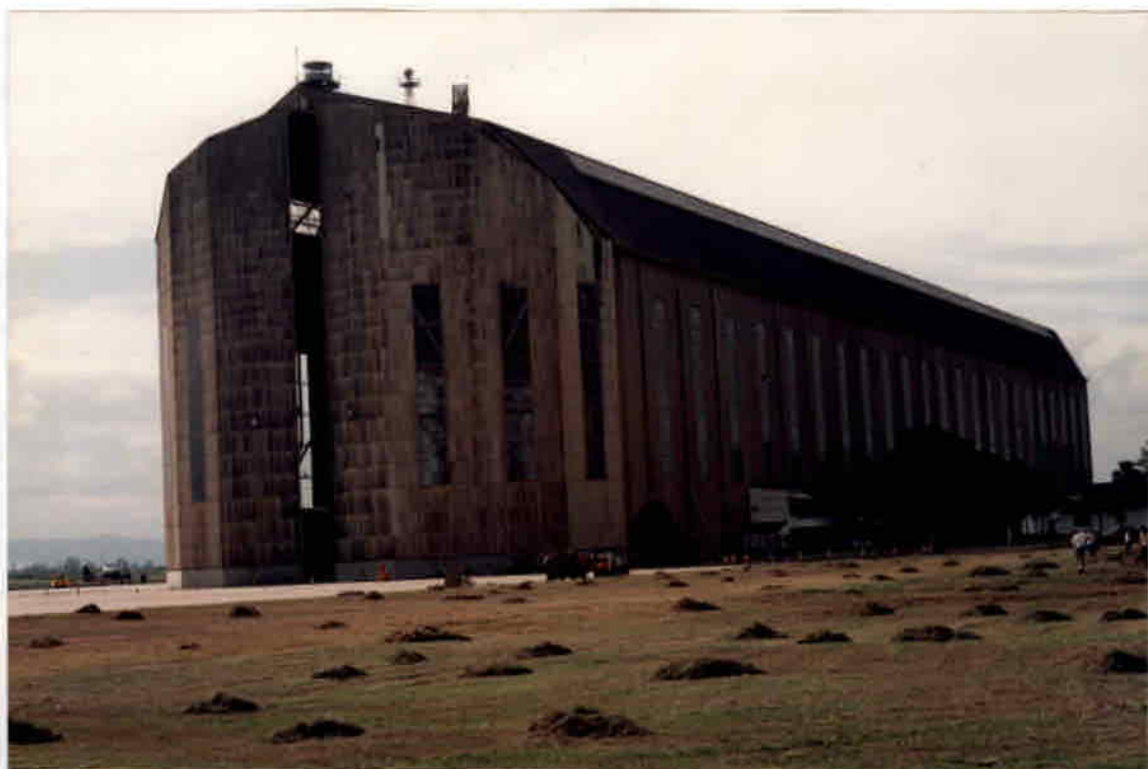
1 - HANGAR, PORTA PRINCIPAL E LATERAL ESQUERDA
