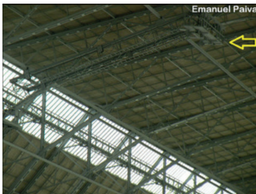
Imagem 48: Fotografia do teto do Hangar do Zeppelin com alguns elementos internos integrados ao edifício. Observa-se uma das escadas com o andaime, feitos em estrutura de aço, que permitiam a manutenção dos dirigíveis em toda a sua altura, cerca de 40 metros. Base Aérea de Santa Cruz, bairro Santa Cruz, Rio de Janeiro. 2013. Autor da imagem: Emanuel Paiva. Fonte: http://www.skyscrapercity.com/showthread.php?t=1584775 . Acesso em: 11 fev. 2015.
