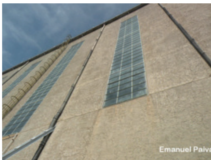
Imagem 42: Fotografia de uma das laterais externas do Hangar do Zeppelin, Base Aérea de Santa Cruz, bairro Santa Cruz, Rio de Janeiro. Verifica-se a combinação do concreto com o vidro na composição arquitetônica verticalizada e despojada de ornamentação. 2013. Autor da imagem: Emanuel Paiva. Fonte: http://www.skyscrapercity.com/showthread.php?t=1584775 .Acesso em: 11 fev. 2015.
