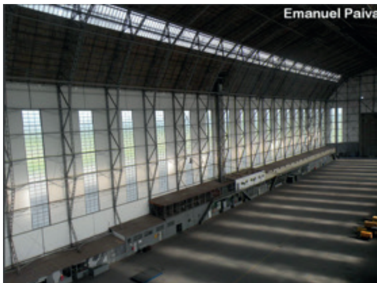
Imagem 51: Fotografia do interior do Hangar do Zeppelin que identifica intervenções junto às paredes laterais com a introdução de edificações com dois pavimentos. Base Aérea de Santa Cruz, bairro Santa Cruz, Rio de Janeiro. 2013. Autor da imagem: Emanuel Paiva. Fonte: http://www.skyscrapercity.com/showthread.php?t=1584775 . Acesso em: 11 fev. 2015.
