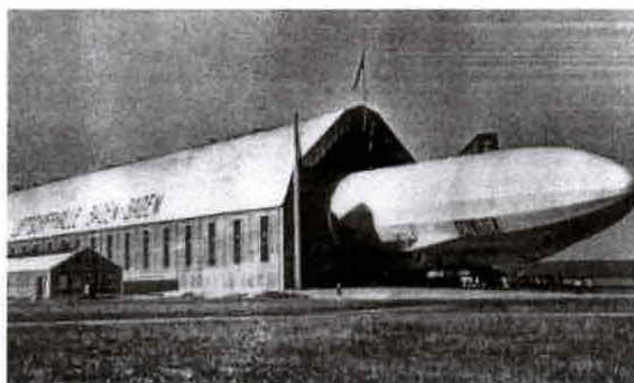
Figura 28 - Hangar de Baden-Baden, Alemanha, construído a custo da cidade, para uso de dirigíveis civis. Observe-se as portas, que geram distúrbios no fluxo do vento.
