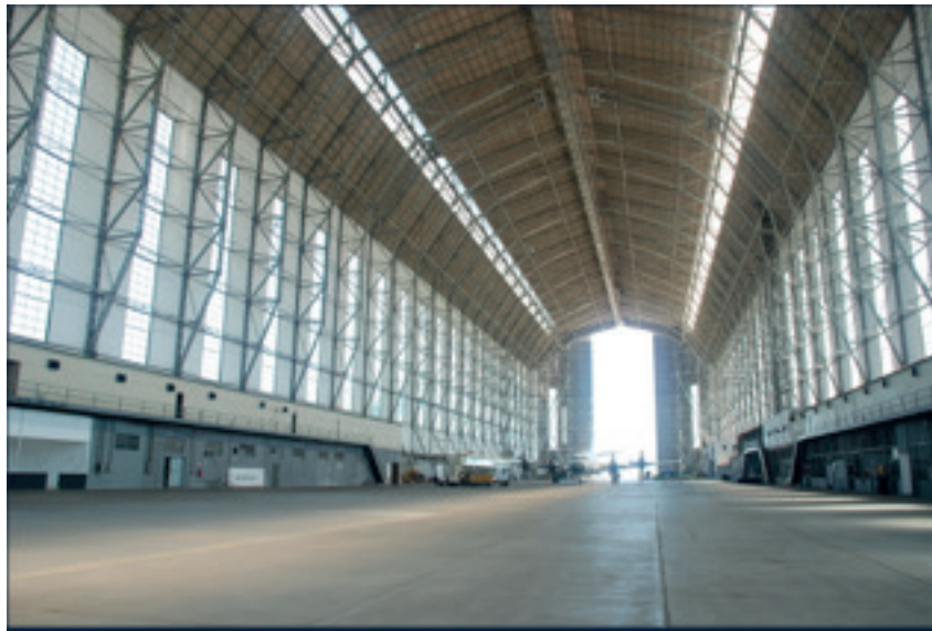
Imagem 40: Fotografia do interior do Hangar do Zeppelin, Base Aérea de Santa Cruz, bairro Santa Cruz, Rio de Janeiro. O racionalismo arquitetônico fazia uso sistemático de formas elementares na composição arquitetônica, obtendo simetria, equilíbrio e regularidade no conjunto. Entre os postulados do movimento estava a correspondência entre forma/edifício e função. Fonte da imagem: Acervo do Ecomuseu do Quarteirão Cultural do Matadouro de Santa Cruz. Autor: Eduardo Rocha. Data: 11 fev. 2015.
