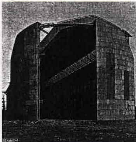
Abb. 4 Vorderansicht der Luftschiffhalle in Friedrichshafen bei halb geöffnetem Tor.
