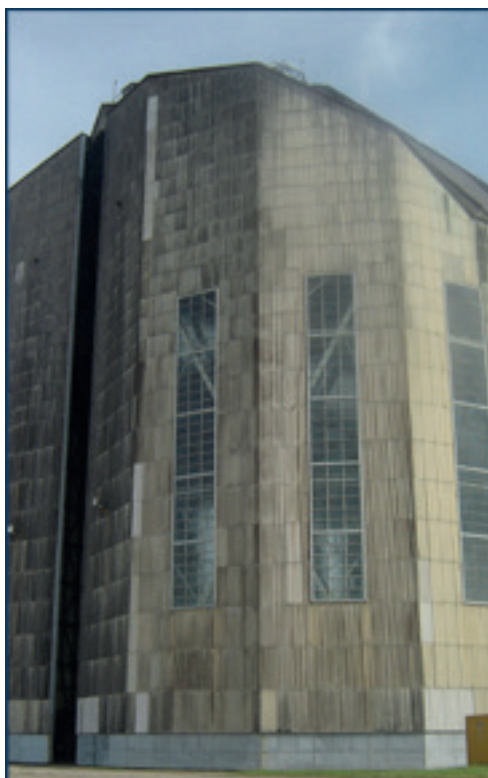
Imagem 43: Fotografia da parte externa do portão sul do Hangar do Zeppelin, Base Aérea de Santa Cruz, bairro Santa Cruz, Rio de Janeiro. O portão franqueia todo o vão útil do edifício e era por onde os dirigíveis entravam no hangar. 2013. Autor da imagem: Emanuel Paiva. Fonte: http://www.skyscrapercity.com/showthread.php?t=1584775 .Acesso em: 11 fev. 2015.
