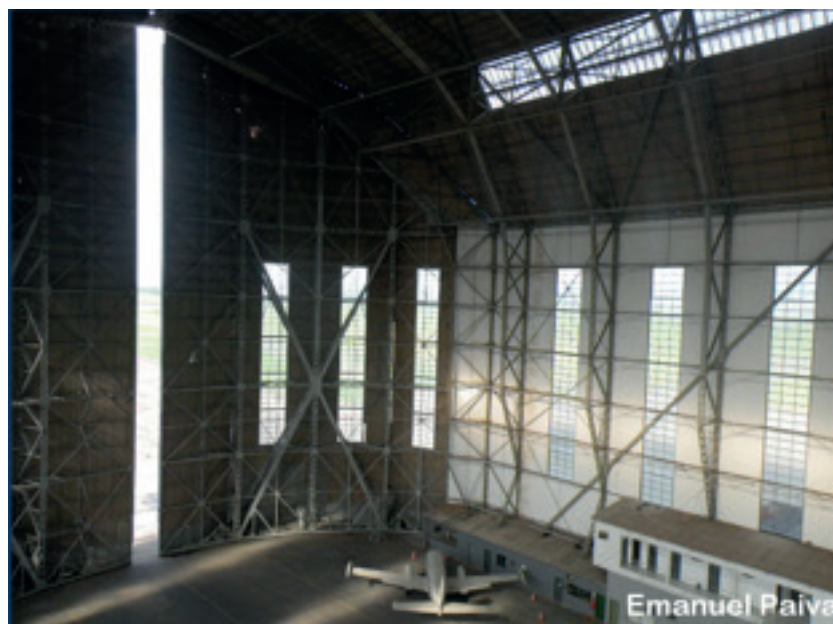
Imagem 44: Fotografia da ala sul do Hangar do Zeppelin, Base Aérea de Santa Cruz, bairro Santa Cruz, Rio de Janeiro. Observa-se a estrutura interna do portão que dava acesso dos dirigíveis ao hangar. 2013. Autor da imagem: Emanuel Paiva. Fonte: http://www.skyscrapercity.com/showthread.php?t=1584775 . Acesso em: 11 fev. 2015.
