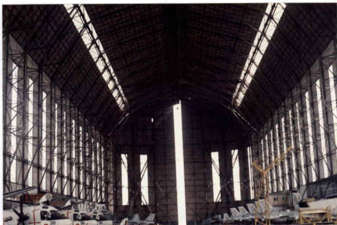
14 - INTERIOR EM DIREÇÃO PRINCIPAL A PORTA PRINCIPAL
