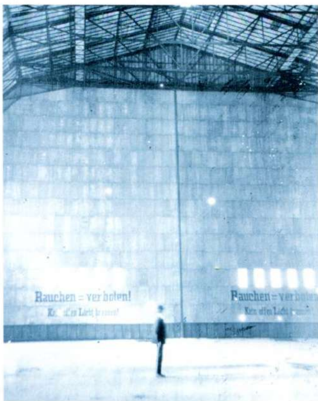
Toska, den dobbelte luftskibshals vestlige ende. Bemærk de to store skydeporte, med det enorme antal af firkantede eternitplader.
