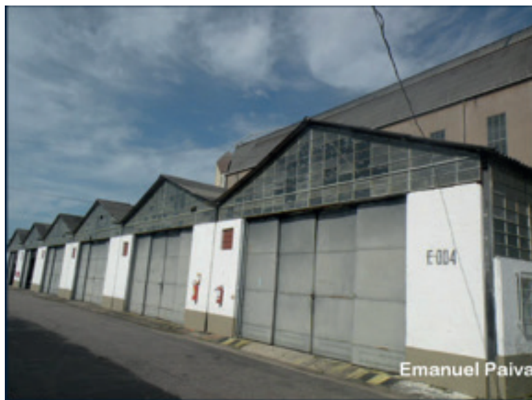
Imagem 52: Fotografia de edificações geminadas na lateral direita (oeste) do Hangar do Zeppelin. Estas construções configuram acréscimo ao projeto arquitetônico original e posicionam-se abaixo do nível das janelas do prédio. Base Aérea de Santa Cruz, bairro Santa Cruz, Rio de Janeiro. 2013. Autor da imagem: Emanuel Paiva. Fonte: http://www.skyscrapercity.com/showthread.php?t=1584775 . Acesso em: 11 fev. 2015.
