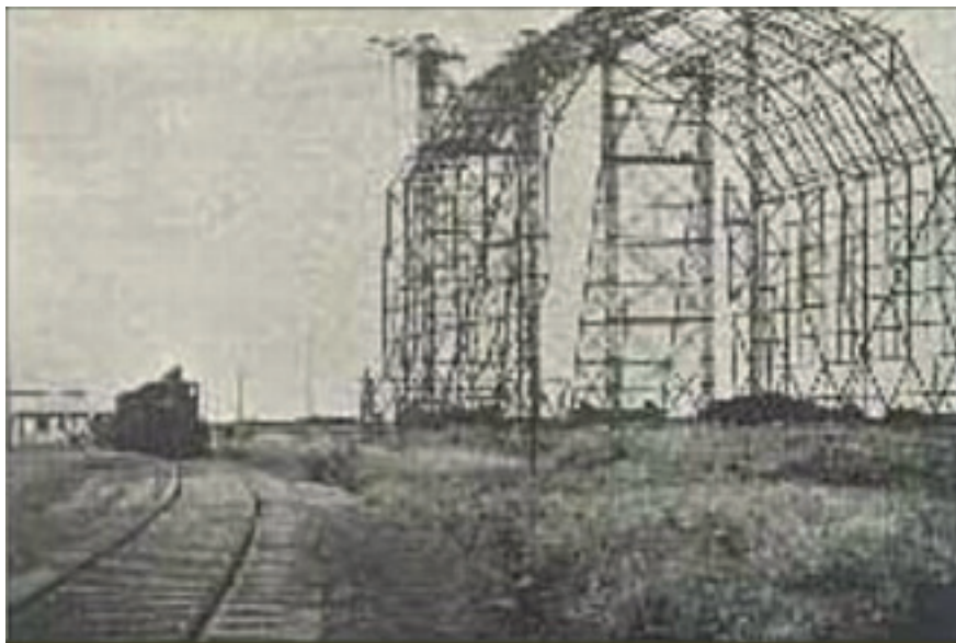
Imagem 6: Fotografia do Hangar do Zeppelin, Aeroporto Bartholomeu de Gusmão, bairro Santa Cruz, Rio de Janeiro, em fase de construção, com a estrada de ferro que ligava o aeroporto à Estação D. Pedro II. 1934. Fonte da imagem: Acervo Base Aérea de Santa Cruz/FAB.
