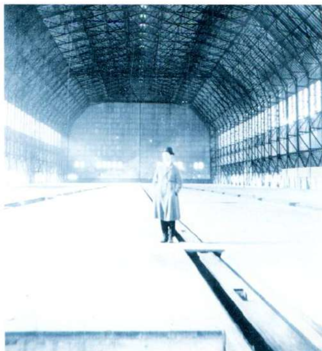
Indvendig i den enorme dobbelte luftskibshal Toska. Billedet er taget i 1922, kort før nedrivningen af dette fantastiske bygningsværk, der var et af Nordeuropas mest besøgte turistattraktioner. Bemærk konstruktionen i gulvet bag personen. På denne skinne løb den såkaldte »Lauf Katze«, altså en »løbekat«, som holdt luftskibet i balance via tove, ved ud- og indmanøvrering.
