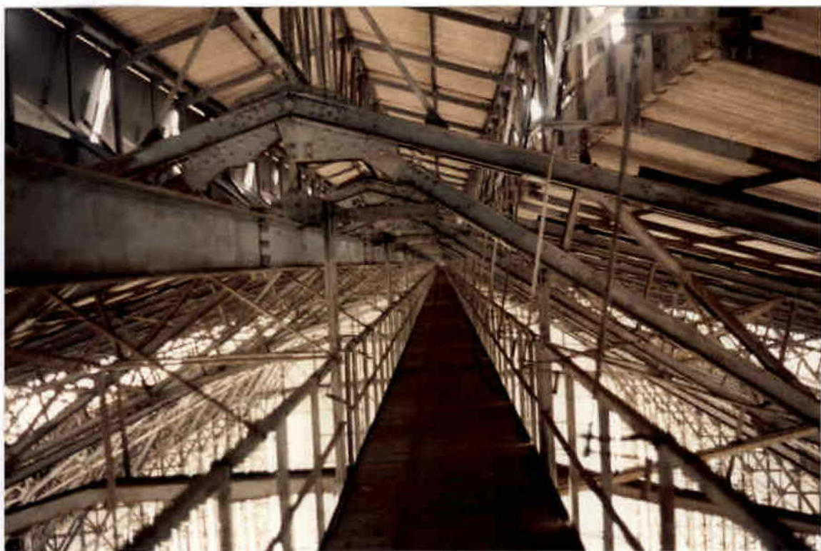
19 - PASSARELA DE INSPEÇÃO NO TOPO DO HANGAR
