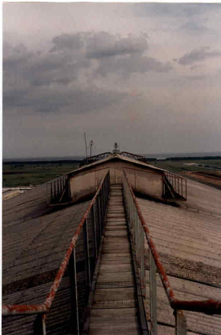
5 - TELHADO, VISTO DA PLATAFORMA DE ACESSO SECUNDÁRIO
