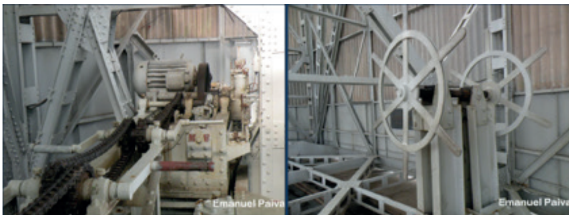
Imagens 45 e 46: Fotografias da maquinaria de abertura do portão sul do Hangar do Zeppelin, Base Aérea de Santa Cruz, bairro Santa Cruz, Rio de Janeiro. Observa-se os mecanismos elétrico e manual. 2013. Autor da imagem: Emanuel Paiva. Fonte: http://www.skyscrapercity.com/showthread.php?t=1584775 . Acesso em: 11 fev. 2015.
