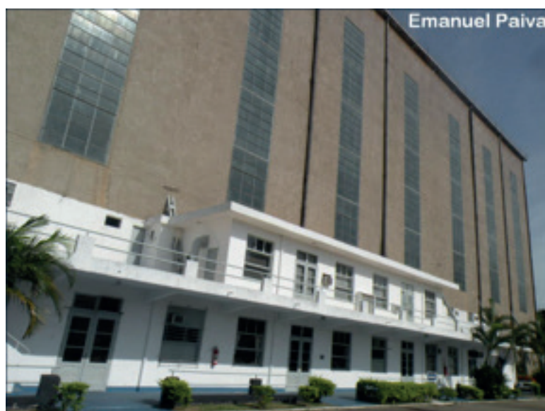
Imagem 53: Fotografia de construção anexa ao Hangar do Zeppelin. Base Aérea de Santa Cruz, bairro Santa Cruz, Rio de Janeiro. Visualiza-se a lateral leste do hangar com edificações, provavelmente, do projeto arquitetônico original do Aeroporto Bartholomeu de Gusmão. 2013. Autor da imagem: Emanuel Paiva. Fonte: http://www.skyscrapercity.com/showthread.php?t=1584775 . Acesso em: 11 fev. 2015.
