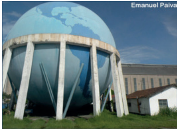
Imagem 50: Fotografia da parte externa do reservatório, próximo ao Hangar do Zeppelin. Algumas fontes indicam que era destinado à reserva de gás que abastecia os dirigíveis, contudo esta construção não é identificada em fotografias da época em que o Aeroporto Bartholomeu de Gusmão encontrava-se em atividade, período entre 1936-1937. Base Aérea de Santa Cruz, bairro Santa Cruz, Rio de Janeiro. 2013. Autor da imagem: Emanuel Paiva. Fonte: http://www.skyscrapercity.com/showthread.php?t=1584775 . Acesso em: 11 fev. 2015.
