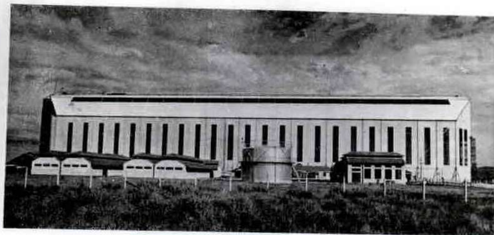
AEROPORTO BARTOLOMEU DE GUSMÃO - DISTRITO FEDERAL - HANGAR DOS DIRIGÍVEIS DEPOSITO DE HÍDRÓGENIO E DEMAIS INSTALAÇÕES
