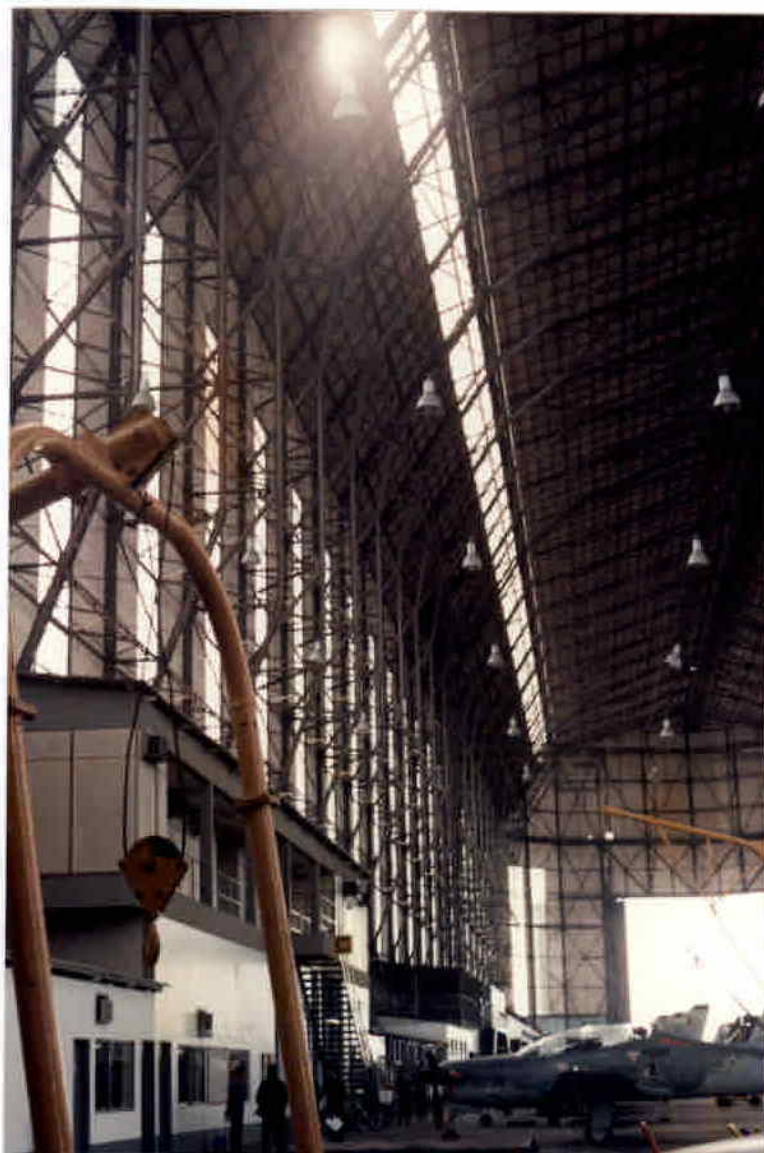
17 - ESTRUTURA DO PRÉDIO COM CONTRUÇÃO FEITAS PARA ABRIGAR INSTALAÇÕES DA FAB
