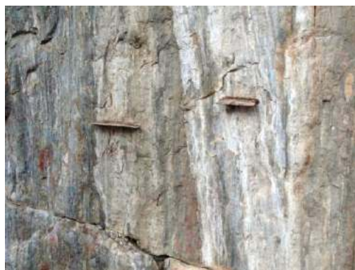
Figura 27 – Após a instalação de pingadeiras – Sítio Mirador de Parelhas – Parelhas – Rio Grande do Norte.
