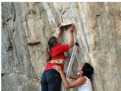
Figura 26 – Instalação de pingadeiras – Sítio Mirador de Parelhas – Parelhas – Rio Grande do Norte.
